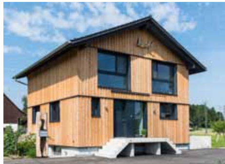
Aussenfassade mit Douglasienholz aus dem eigenen Wald
