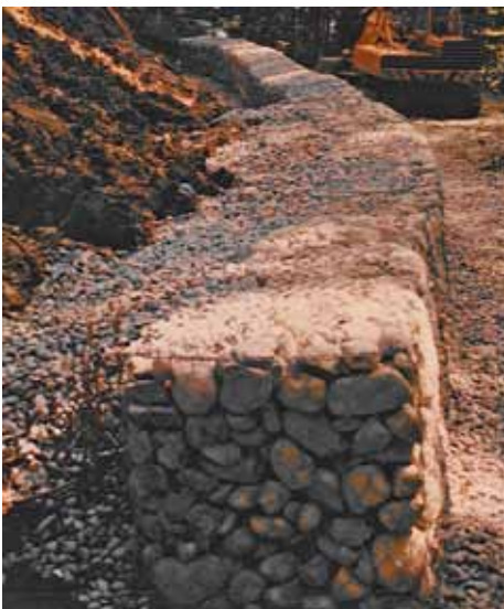
Steinkorbverbauung im skizzierten Querprofil und kurz vor der Fertigstellung.
