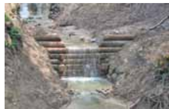
Einfache Holzsperrre aus Lärche; geplant und nach Ausführung
