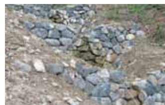
Blocksteinsperrren; geplant und nach Ausführung
