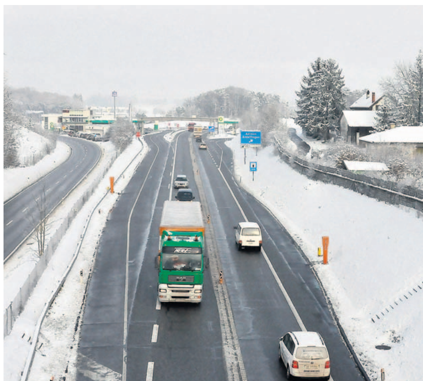
Blick auf die A4-Ausfahrt «Adlikon». Rechts im Bild sind die Häuser zu sehen, die abgerissen werden sollen. Bild: Vincent Fluck
