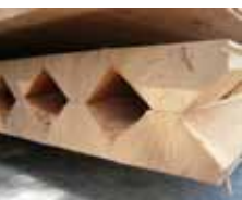
Innovative Tragkonstruktion aus Buchenholz.
