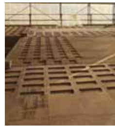
Eine Weltneuheit kommt zum Einsatz: eine Holz-Beton-Verbunddecke mit Buchenholz
