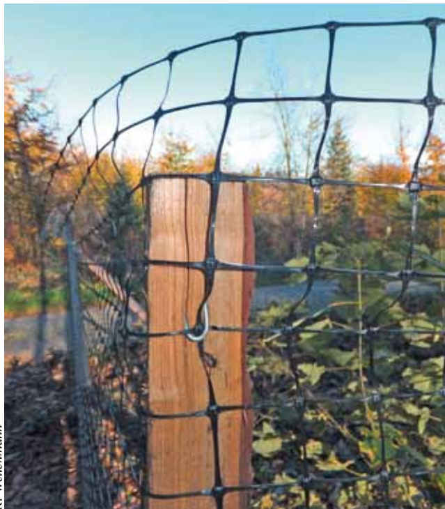
Abb. 6: Zaun mit Kunststoffgeflecht – die Pfahllänge ist nicht auf das neue Produkt abgestimmt.
