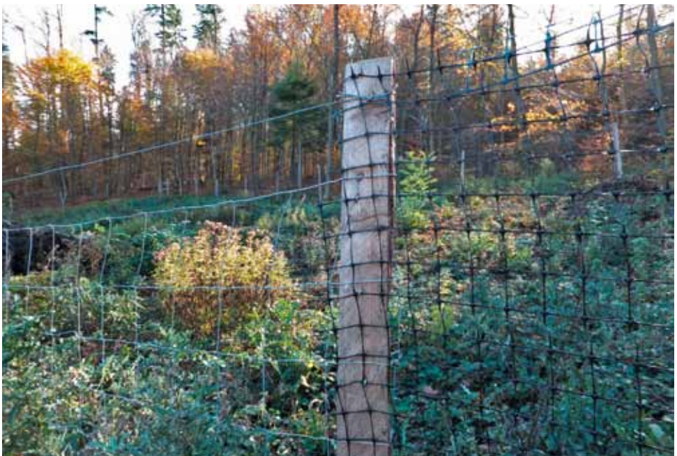
Abbildung 5: Draht- und Kunststoffgeflecht. Beim Kunststoffgeflecht ist der Sprungdraht überflüssig.
