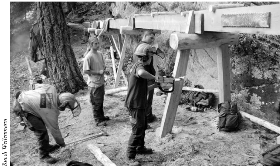
Instandstellung eines Bewässerungskanals
