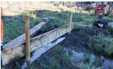
Abbildung 5: Rütliwald. Oben: Hauptentwässerungsgraben «Martinsbrünnelbächli»; unten: Regeneration durch Einstau eines Entwässerungsgrabens
