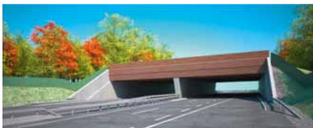
Geplante Wildbrücke Neuenkirch LU. Überspannung der Autobahn mit Brettschichtholzträgern in zwei Etappen. Flächige Abdeckung mit Sperrholzplatten. Übertragung der vertikalen und horizontalen Kräfte auf die Stahlbetonwände durch Hartholzklotze. Flachfundation.
