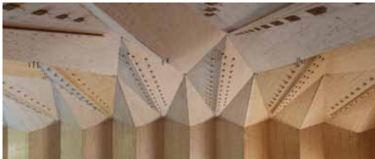
Brettsperrholz (BSP) ist im modernen Holzbau vielseitig einsetzbar. Z.B. im Théâtre de Vidy in Lausanne. © Blumer-Lehmann AG, Foto: Ilka Kramer
